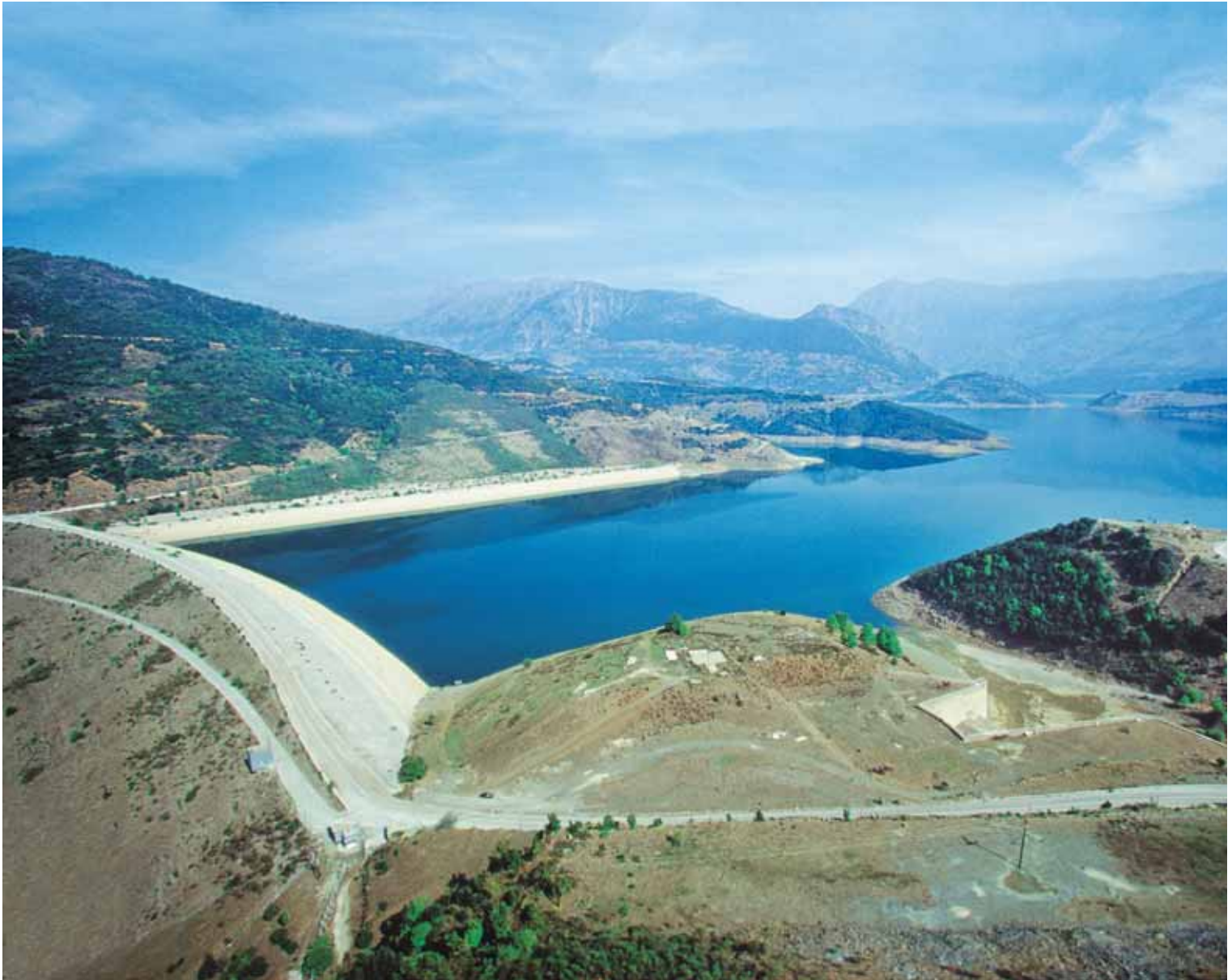
Φράγμα και ταμιευτήρας Μόρνου. 2000
