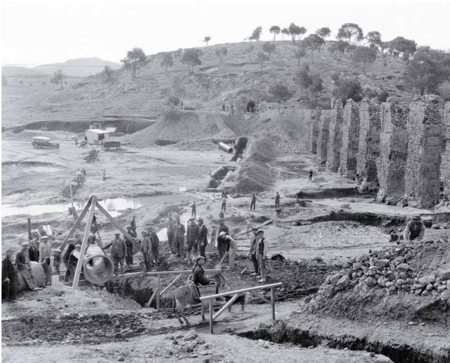
Τοποθέτηση αγωγού στο Αδριάνειο υδραγωγείο. 1929
