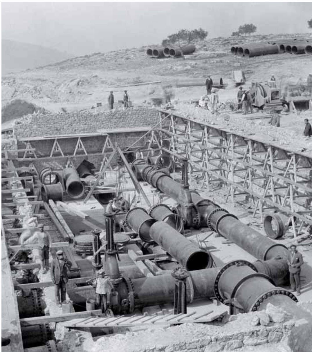
Κατασκευή διυλιστηρίου Γαλατσίου. 1927
