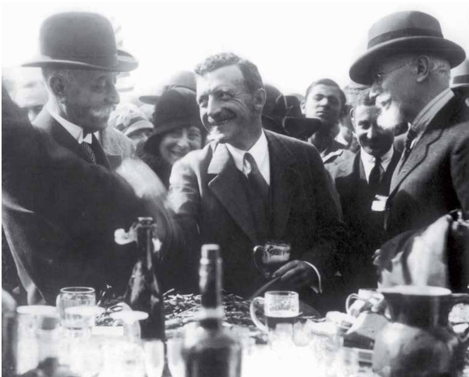
Εγκαίνια φράγματος Μαραθώνα. 1929
