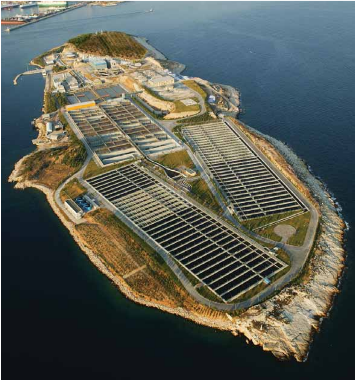
Κέντρο Επεξεργασίας Λυμάτων Ψιττάλειας. 2008
