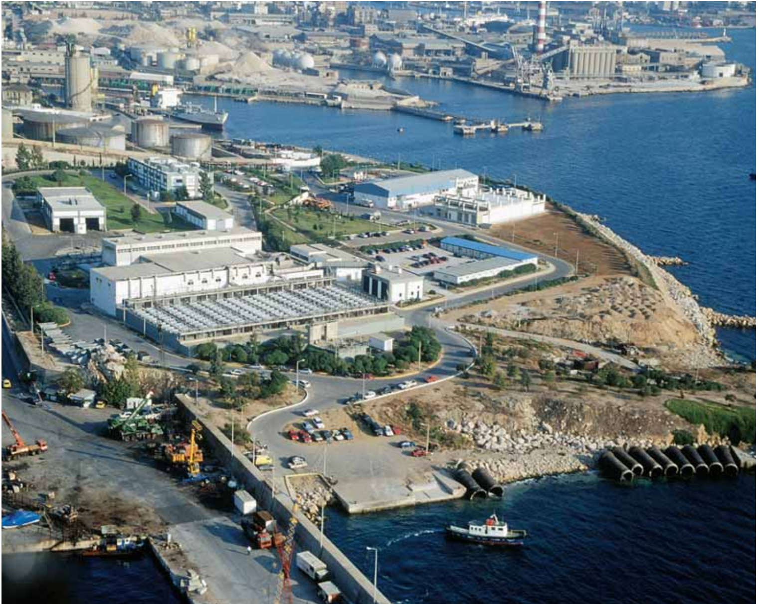
Κέντρο Επεξεργασίας Λυμάτων Ψιττάλειας – Ακροκέραμος. 2000
