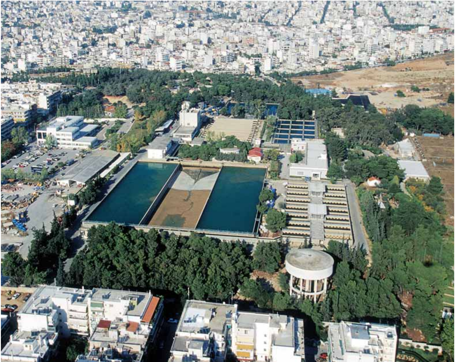
Μονάδα Επεξεργασίας Νερού Γαλατσίου. 2000
