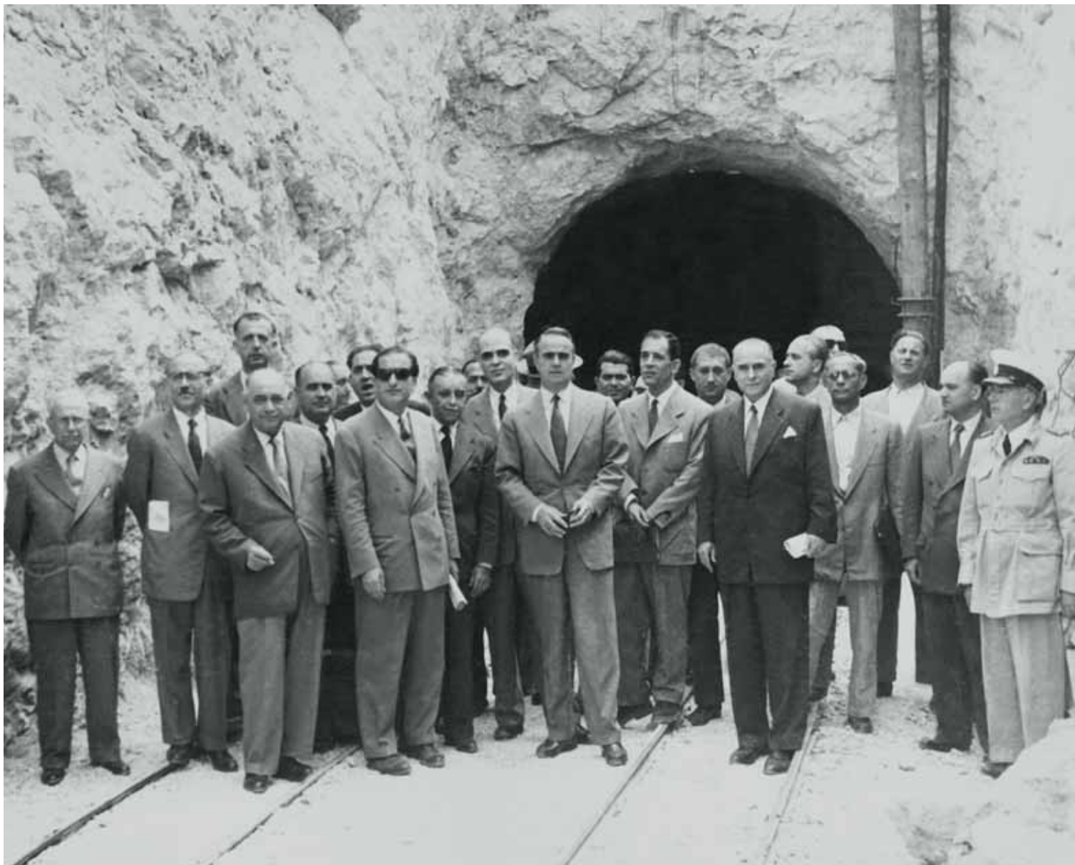
Επίσκεψη του Κωνσταντίνου Καραμανλή στο έργο της σήραγγας του υδραγωγείου Υλίκης. 1955
