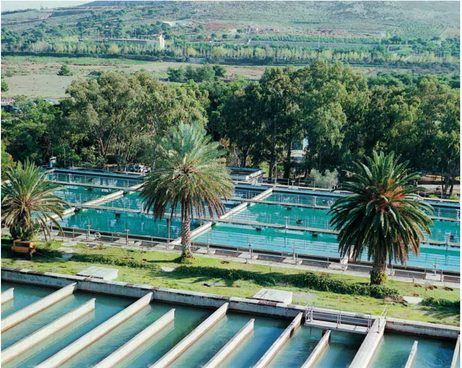
Μονάδα Επεξεργασίας Νερού Γαλιταίου. 2000
