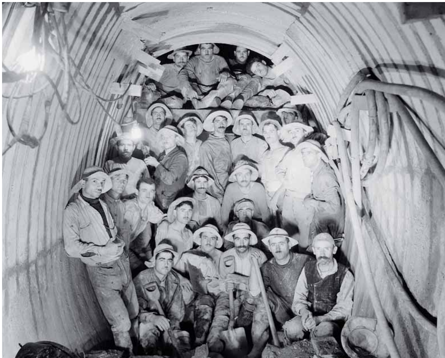
Κατασκευή σήραγγας Μπογιατίου. 1928
