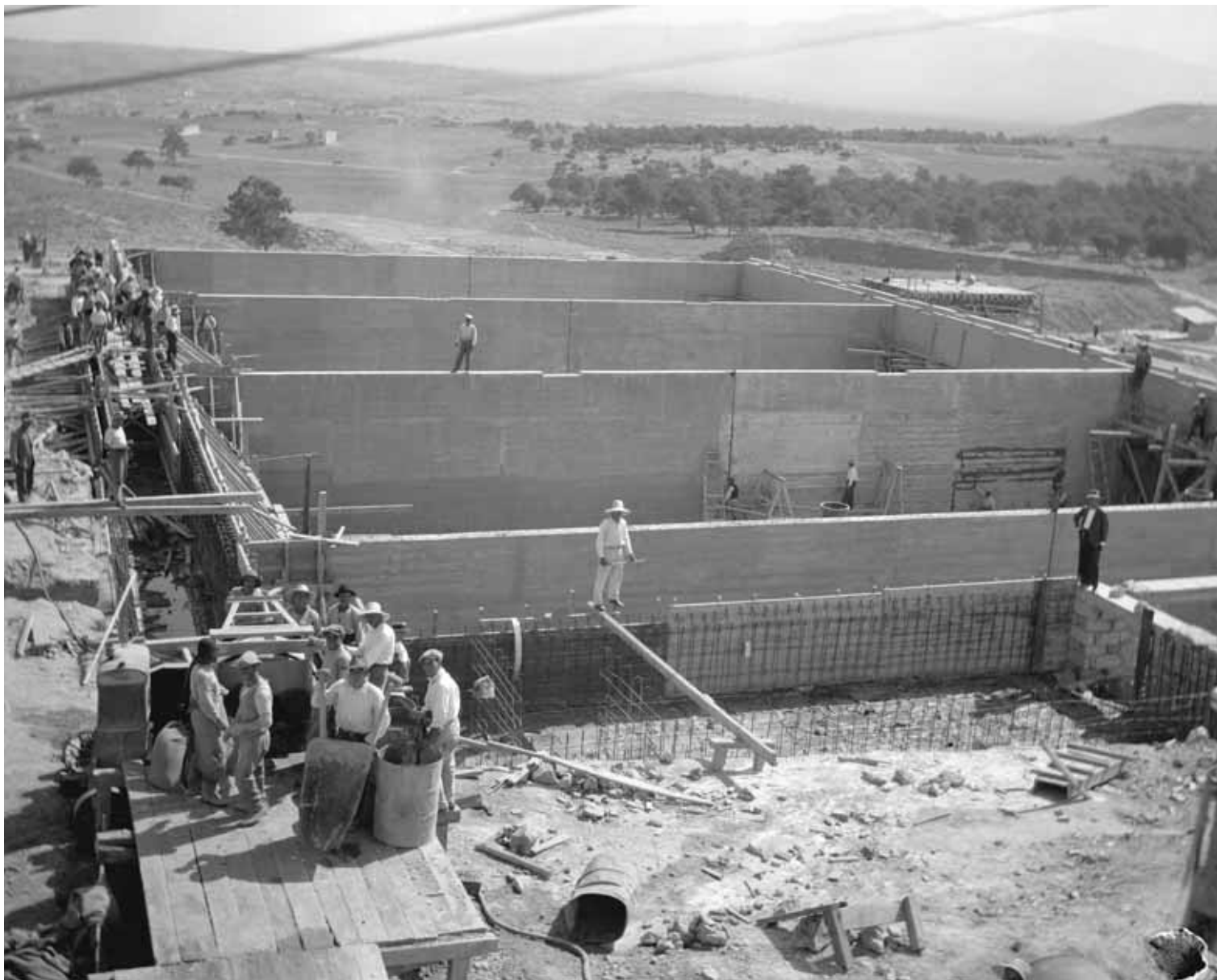
Κατασκευή διυλιστηρίου Γαλατσίου. 1927
