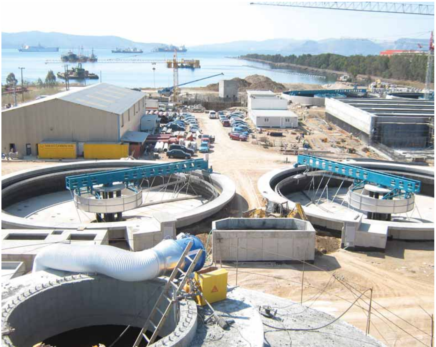
Κέντρο Επεξεργασίας Λυμάτων Θριασίου Πεδίου.2010
