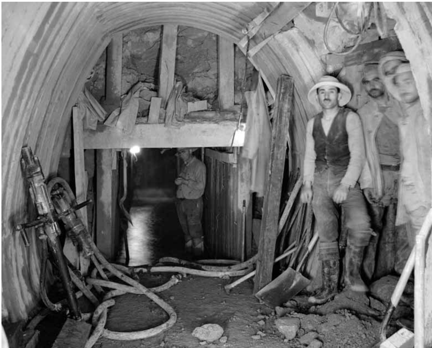
Κατασκευή σήραγγασ Μπογιατίου. 1927
