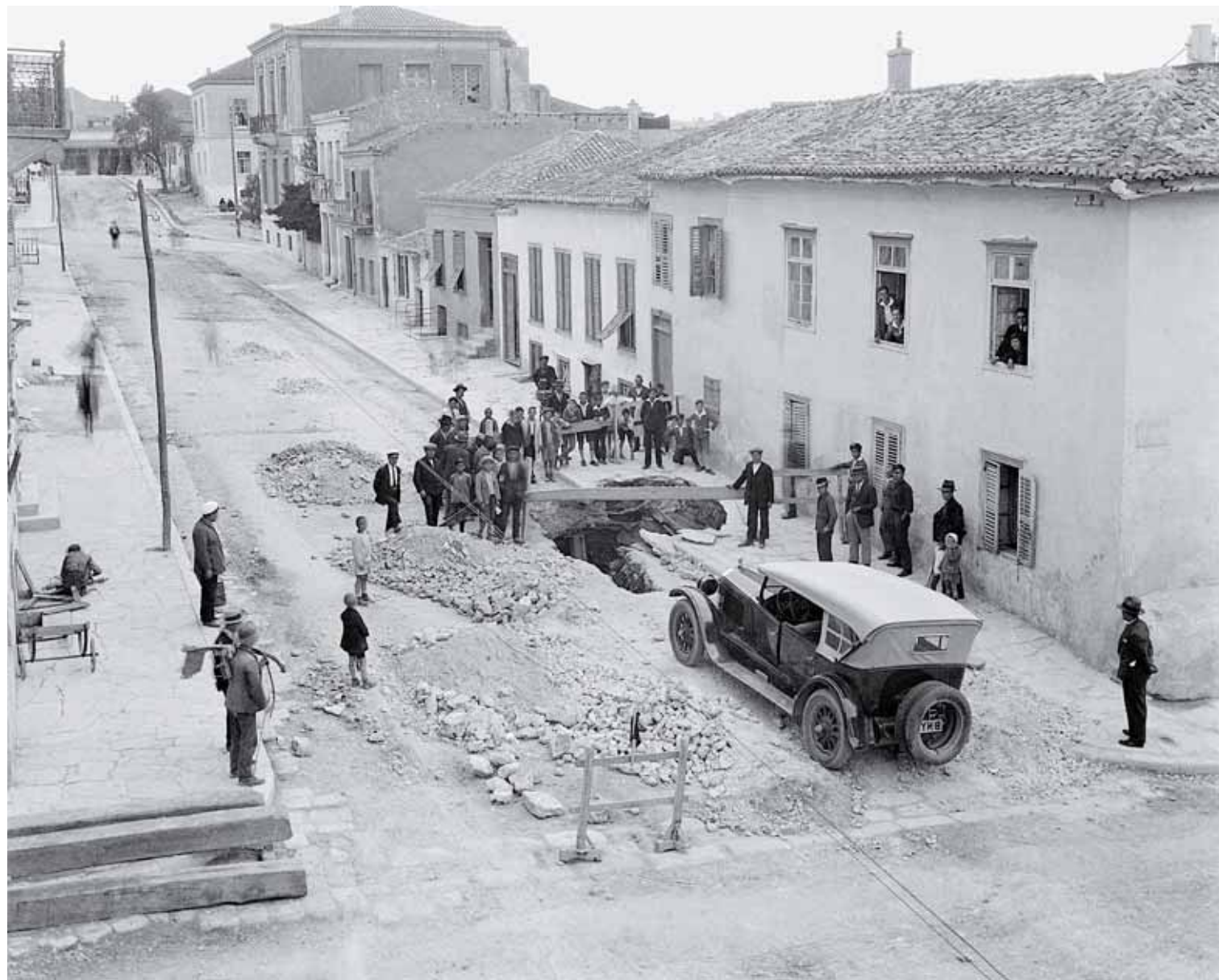
Επισκευή αγωγού εντός πόλεως. 1930
