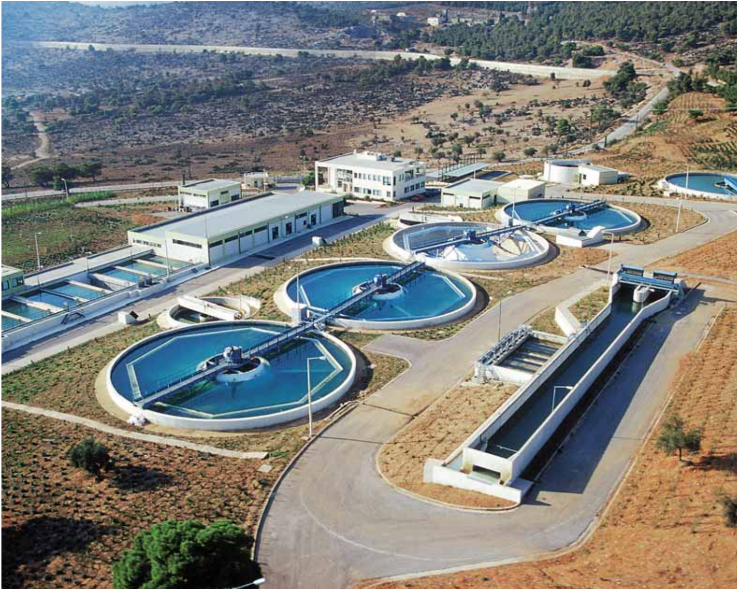
Μονάδα Επεξεργασίας Νερού Ασπροπύργου. 2000
