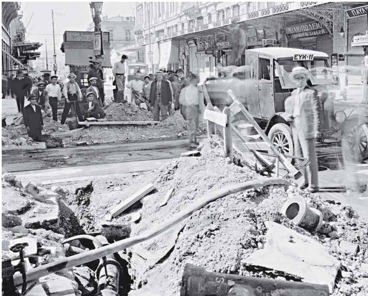
Επισκευή αγωγού στην οδό Σταδίου. 1936
