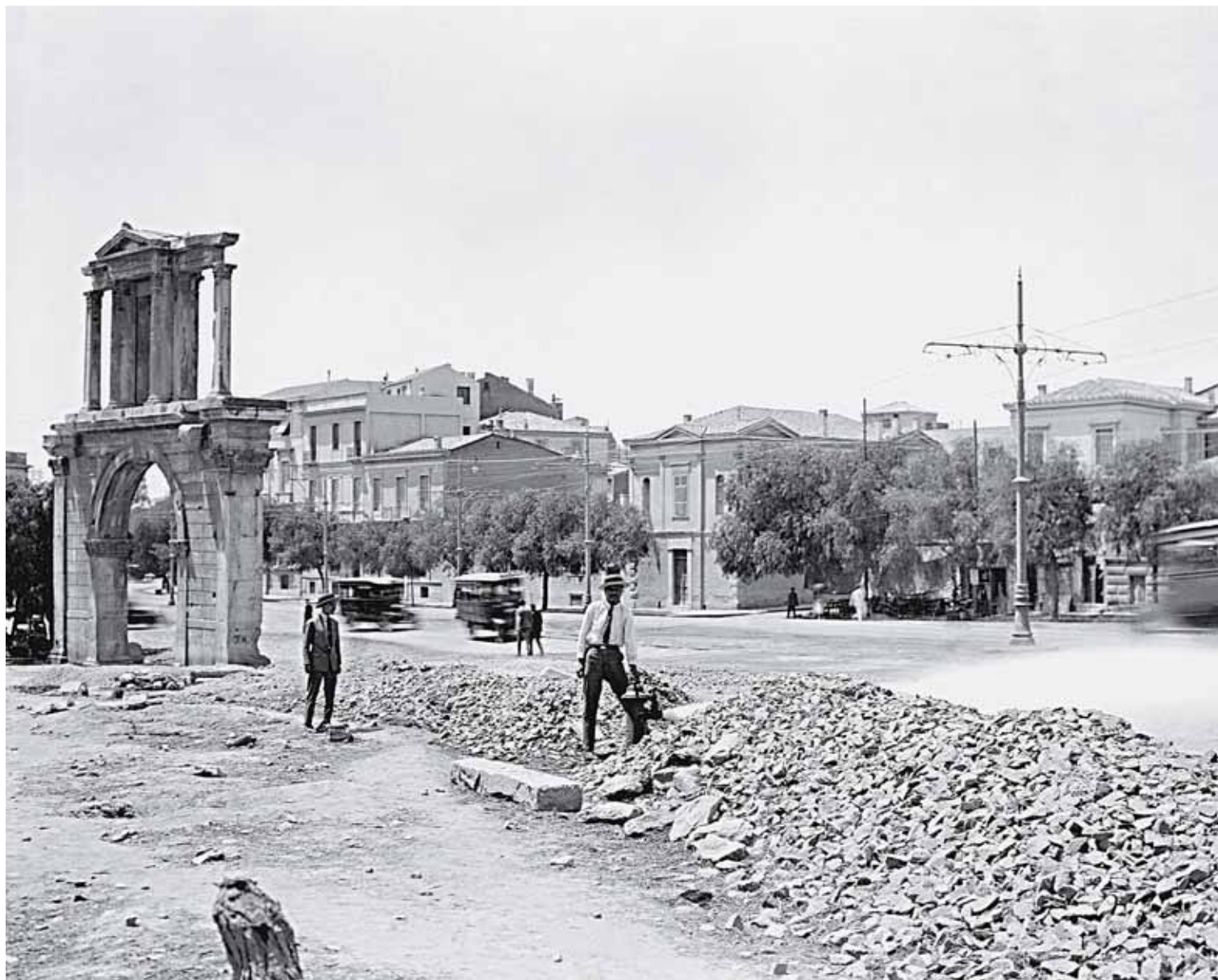
Τοποθέτηση αγωγού εντός πόλεως. 1932
