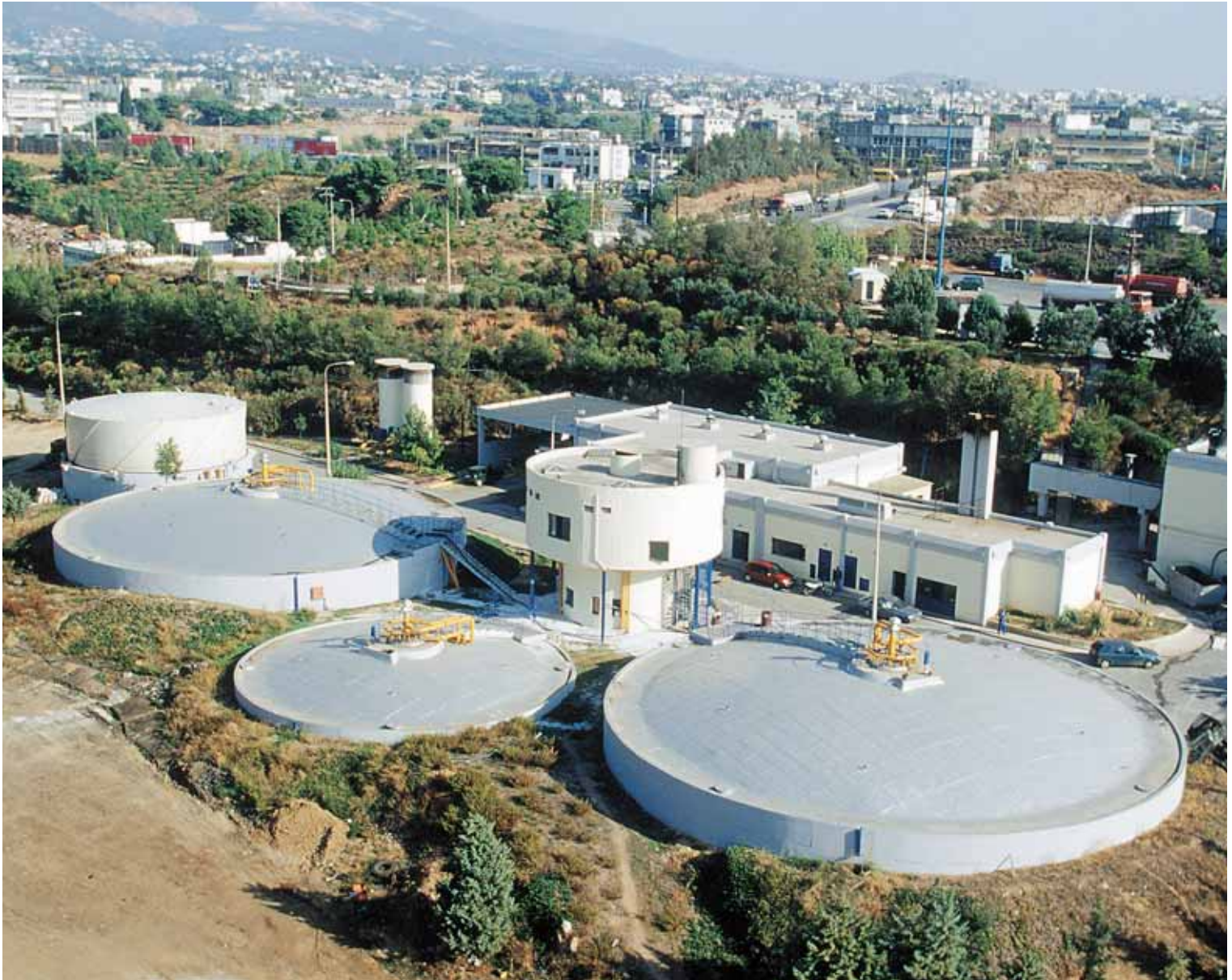
Κέντρο Επεξεργασίας Λυμάτων & Βοθρολυμάτων Μεταμόρφωσης. 2000
